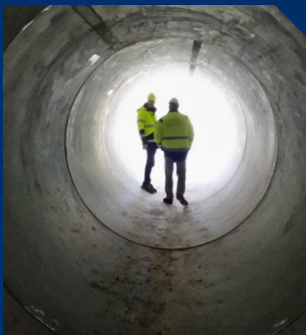
Valby skybrudstunnel København
